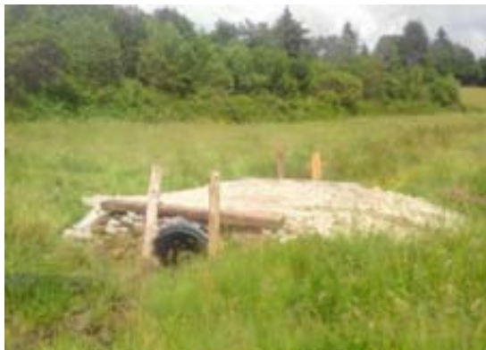
Illustrations de l'installation d'un dispositif de franchissement de type PEHD (Sources : CEN L et Syndicat Mixte du BV de la Touques) et d'une pompe à museau (Sources : Syndicat Mixte du Trégor)
